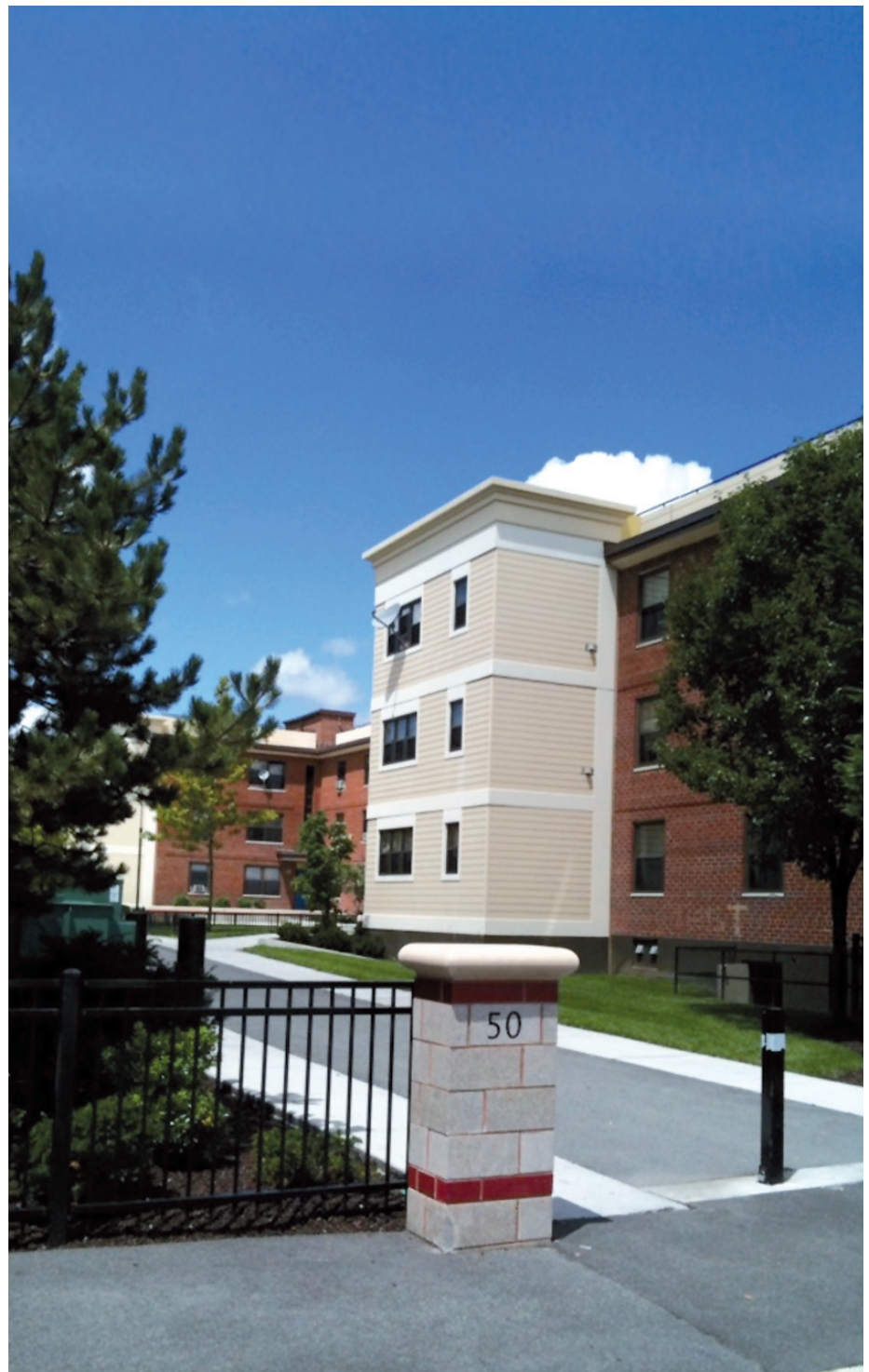
↑ Edificio de vivienda construido con módulos prefabricados de concreto.
